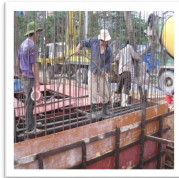
Đổ bê tông Concrete Pouring
