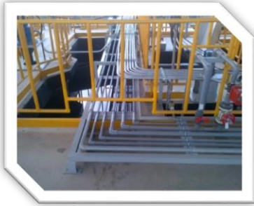
Lắp đặt hệ thống ống PVC Pipe installation
