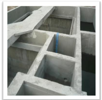
Kiểm tra Leakage Test
