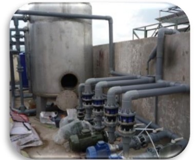
Lắp đặt bơm Pumps installation
