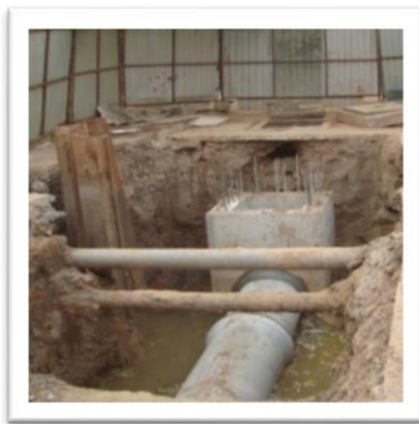
Lắp đặt đường ống Pipe installation
