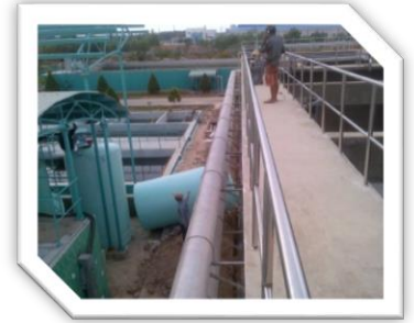
Hành lang công tác SUS Pipe installation
