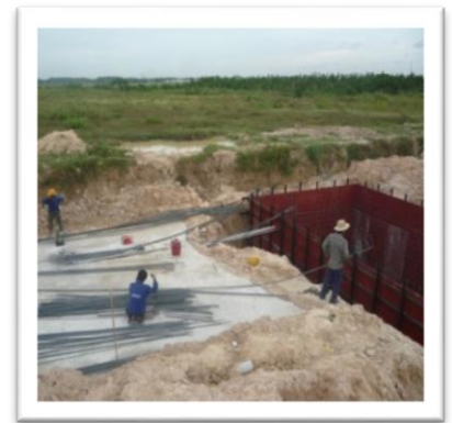
CT Cốt thép, cốt pha Rebar & Formwork
